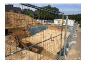
Der Mutterboden wird auf dem Grundstück gelagert und später, soweit geeignet, zur Verfüllung der Arbeitsräume bis zum natürlichen Geländeniveau wiederverwendet. Anschließend werden die Baugrube, die Rohrgräben, (innerhalb des Grundstückes) etwaige Fundamentgräben und der erforderliche Arbeitsraum ausgehoben.
